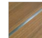
Profil aluminiowy o szerokości 8mm (w kolorze stali nierdzewnej / INOX) zlicowany z powierzchnią skrzydła drzwiowego.
